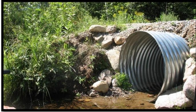
Présence d'un peu de lessivage en provenance du remblai de ponceau (zone 11).
