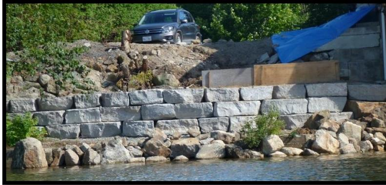
Construction d'un muret en bloc dans la rive (zone 31).
